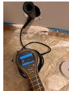
Fuktmåling i vegg mot våtsone.
