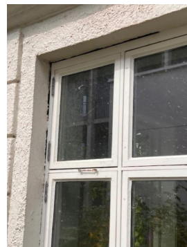
Fuging mangler på utside av vindu
