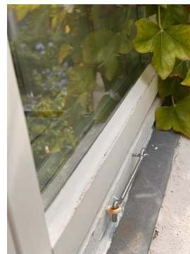
Fuging mangler på utside av vindu
