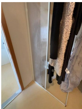
Skadet dusjvegg og øvrige vegger er tatt bort.
